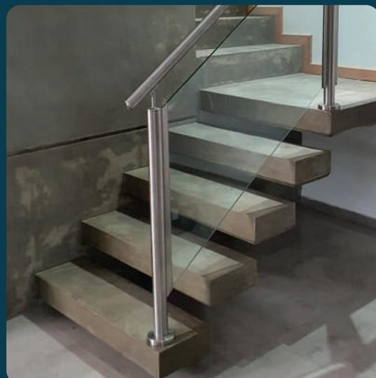
Soportes inferiores para atornillar la baranda al suelo con bases que permiten ocultar los tornillos.
